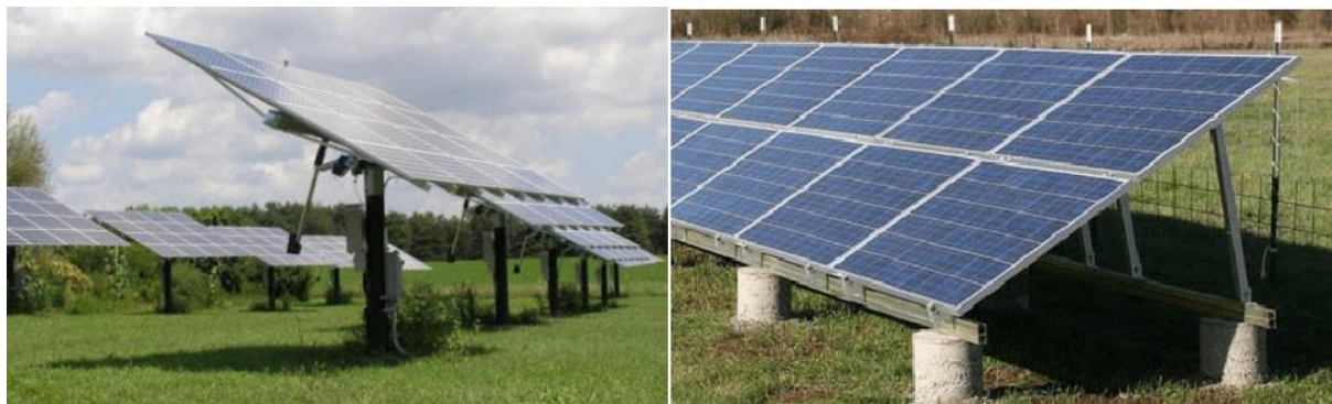
Rysunek 20. Wariant inwestorski – po prawej system z trackerami, po lewej system fixed tilt
