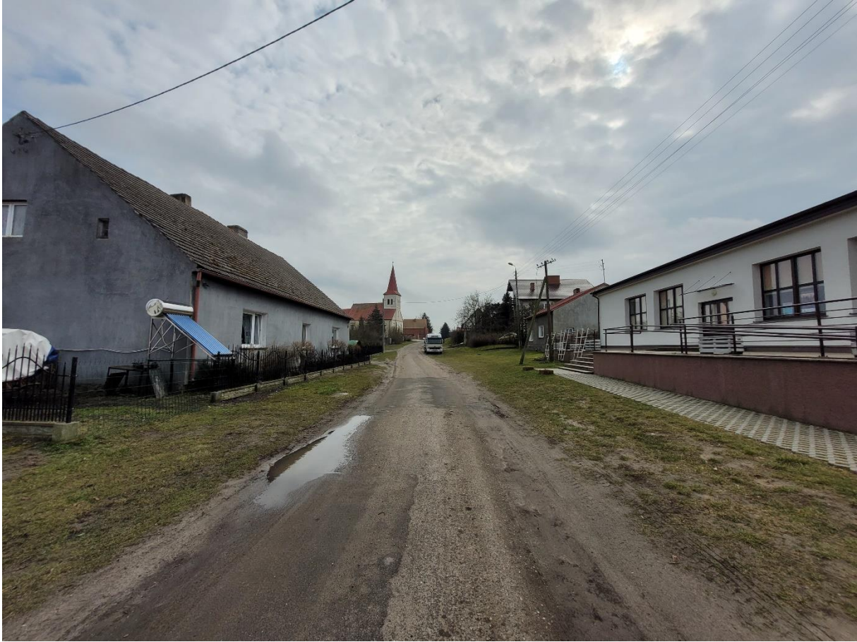
Rysunek 15 Droga gminna zlokalizowana przy świetlicy wiejskiej w Róży Wielkiej
